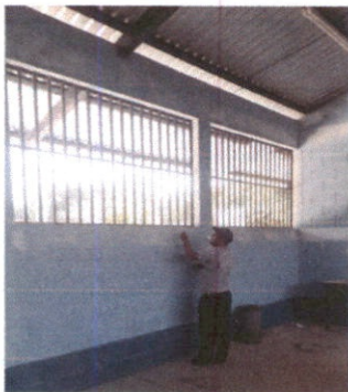
Foto 3: Fabricacion e instalacion de ventanas balcón de metal
