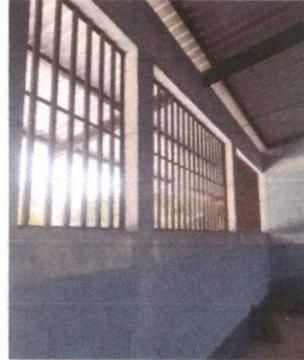
Foto 2: Fabricacion e instalacion de ventanas balcón de metal
