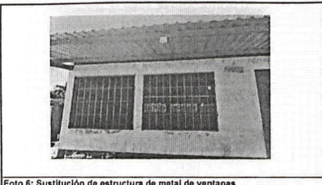
Foto 6: Sustitución de estructura de metal de ventanas
