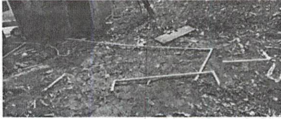
FOTO 1 . Reparacion tubería agua potable
