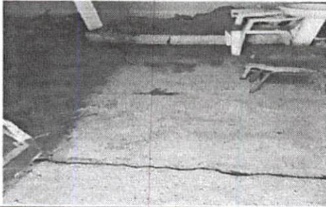
Sustitución de piso interior de cocina
