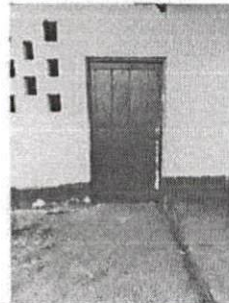
Sustitución de puertas de cocina
