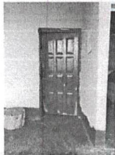
Sustitución de puerta de dirección
