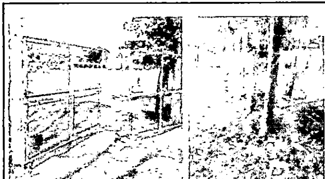
Foto 1: Sustitución de portón de metal y reparación de malla galvanizada, con alambre de pua
