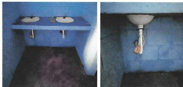
Foto 5: Sustitucion de lavamanos
