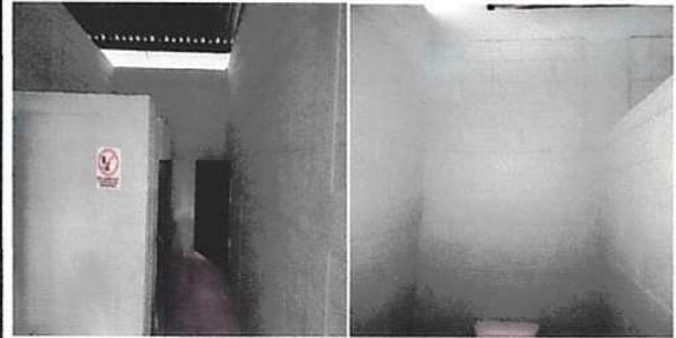
Foto 8: pintura en muros exteriores e interiores
