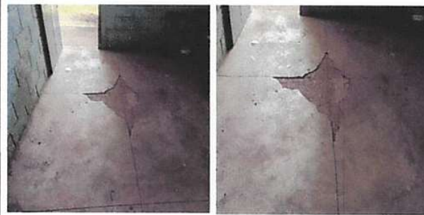
Foto 3: Reparación de piso de cemento líquido
