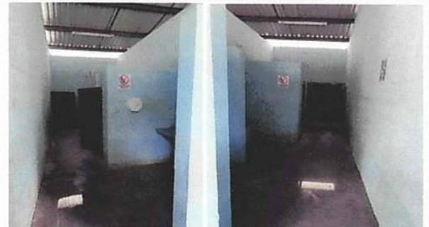
Foto 8: Pintura en muros exteriores e interiores
