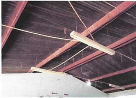
Foto 7: Sustrucción de ducto eléctrico mas accesorios
