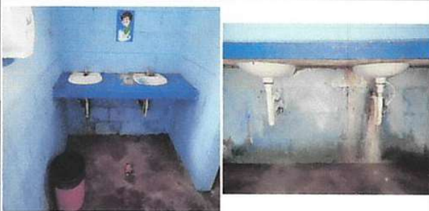
Foto 5: Sustitución de lavamanos
