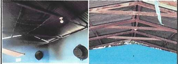
Foto 2: Sustitución de estructura de soporte de madera, por metal
