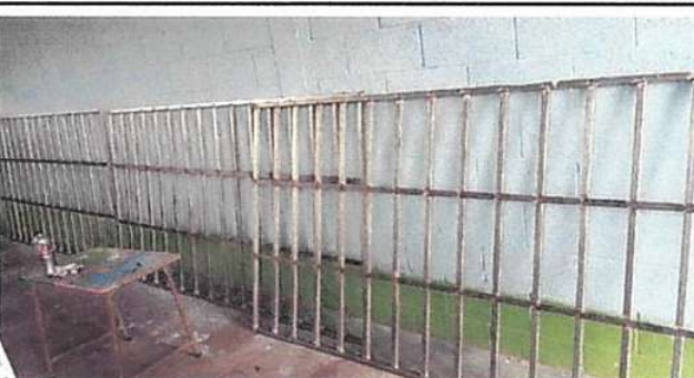
Foto 3: 5. Ventanas: 5.6 Sustitución de balcones de metal.
