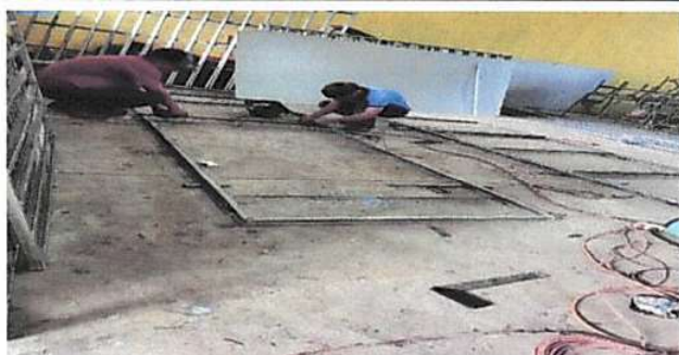
Foto 1: 4. Puertas de metal: 4.3 Sustitución de puerta.
