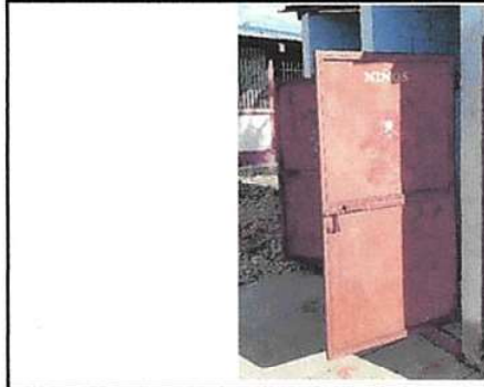
Foto 2: 4. Puertas de metal: 4.4 Sustitución de puerta en servicios sanitarios.
