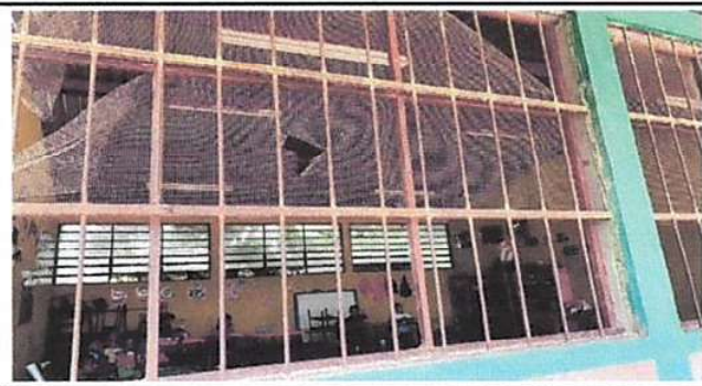
Foto 3: 5. Ventanas: 5.6 Sustitución de balcones de metal.
