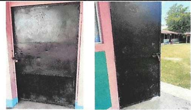
Foto 1: 4. Puertas de metal: 4.3 Sustitución de puerta.
