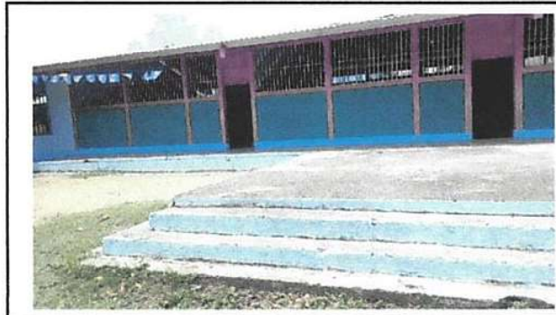
Foto 4: 6. Piso: 6.5 Sustitución de piso de torta de concreto
