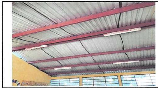
Foto 6: 17. Reparación de Sistema Eléctrico: 117.3 Sustitución de lámparas tipo LED.
