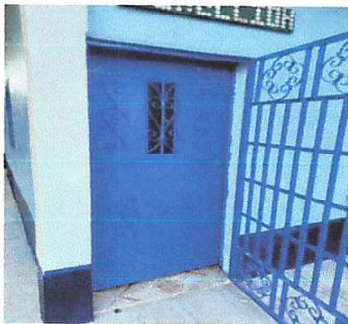
Foto 5: Mantenimiento a estructura
