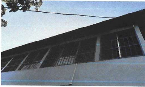
Foto 7: Mantenimiento a marcos mill finish
