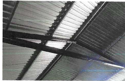
Foto 4: Sustitución de estructura de soporte de metal por metal
