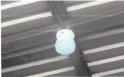
Foto 15: Sustitución de focos ahorradores
