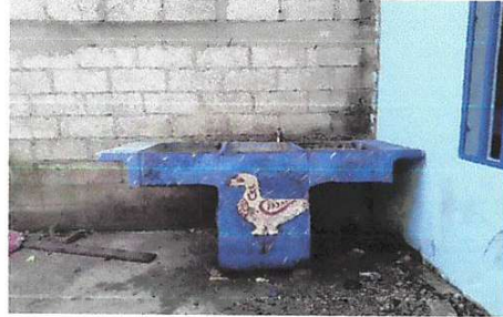
Foto 20: Sustitución de pila de cemento de dos lavaderos
