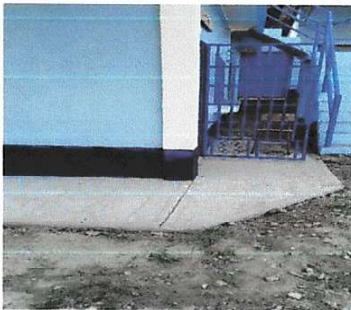
Foto 9: Reparación de banqueta de concreto
