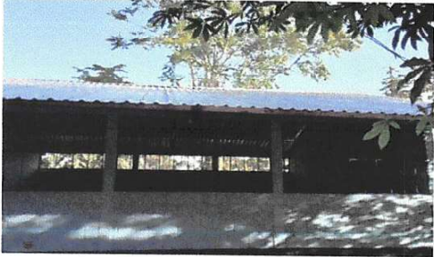
Foto 1: sustitución de lámina, por lamina troquelada aluzinc calibre 26
