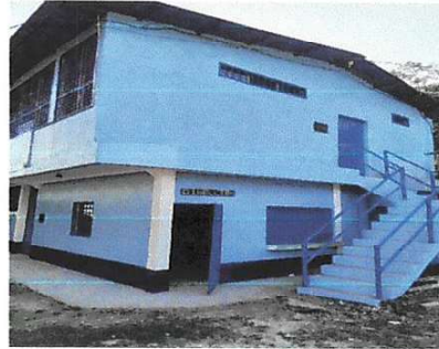
Foto 10: Pintura en muros exteriores e interiores
