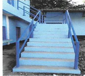
Foto 14: Mantenimiento a barandas de metal
