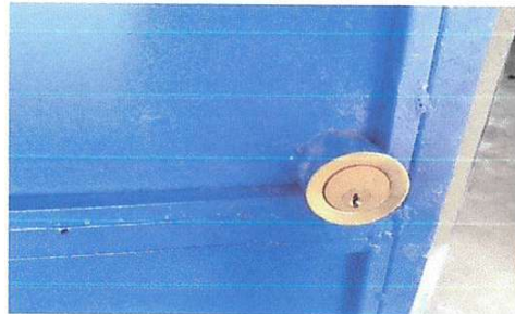
Foto 6: Sustitución de chapa
