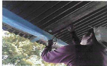
Foto 18: Sustitución de ducto eléctrico + accesorios
