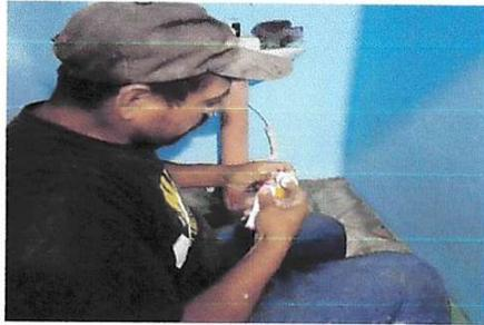
Foto 13: Sustitución de llave de paso
