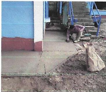
Foto 9: Reparación de banqueta de concreto
