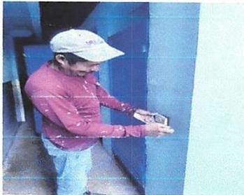
Foto 17: Sustitución de interruptores simples
