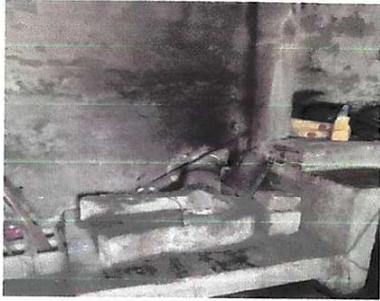
Foto 19: Reparación de chimenea de concreto
