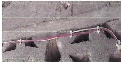
Foto 18: Sustitución de ducto eléctrico + accesorios
