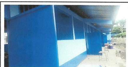
Foto 3: Mantenimiento a balcones de metal
