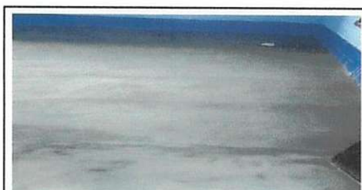
Foto 4: Reparación de piso de torta de concreto
