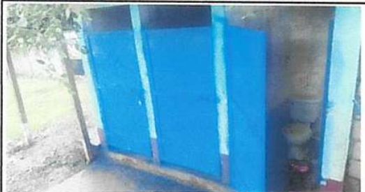
Foto 1: Mantenimiento a estructura (lijado, cambio de tubo , cepillado, sujeciones, aplicación de pintura) a puertas servicios sanitarios
