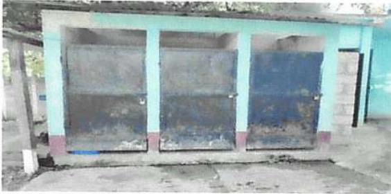
Foto 1: Mantenimiento a estructura (lijado, cambio de tubo , cepillado, sujeciones, aplicación de pintura) a puertas servicios sanitarios
