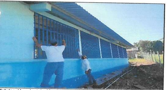
Fabricación e instalación de ventana-balcon de megal
