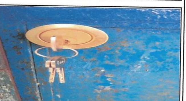
Foto 6: Sustitución de chapa
