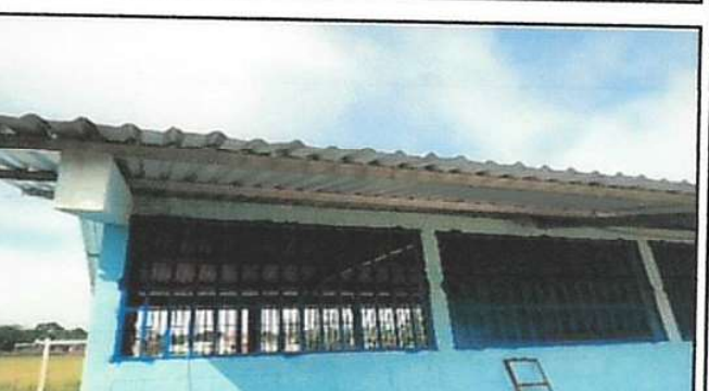
Foto 4: Sustitucion de estreutura de soporte de metal pormetal
