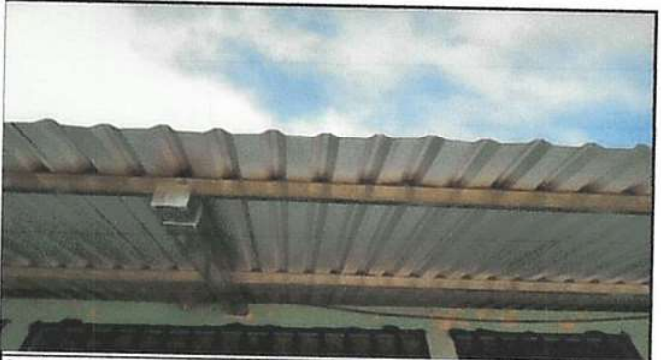
Sustitución de estreutura de soporte de metal por metal
