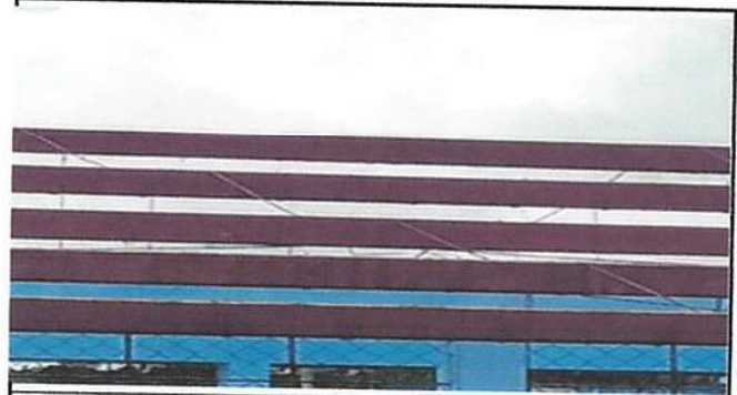
Foto 4: Sustitución de estructura de soporte de metal por metal
