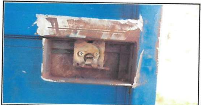
Foto 6: Sustitución de chapa
