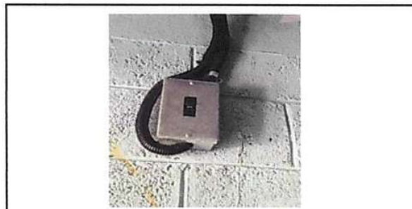
Foto 10: Sustitución de tablero de flipones
