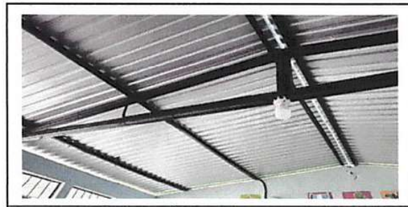
Foto 12: Sustitución de ducto eléctrico + accesorios
