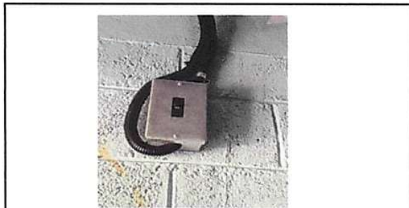
Foto 9: Sustitución de flipones
