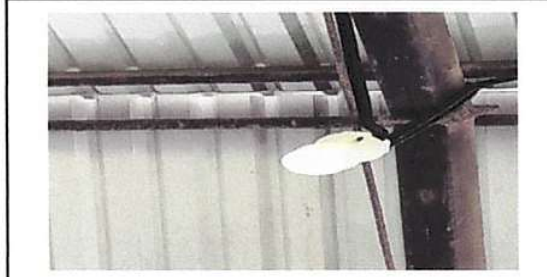
Foto 6: Sustitución de plafoneras
