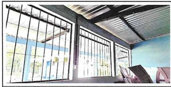
Foto 11: Reparación de cableado eléctrico
