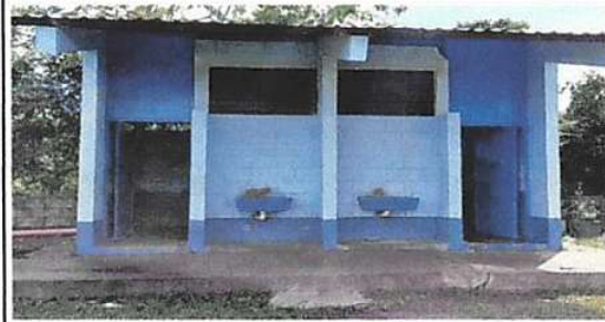
Foto 2: Mantenimiento a estructura (lijado, cambio de tubo , cepillado, sujeciones, aplicación de pintura) a puertas servicios sanitarios (aplicación de pintura)
