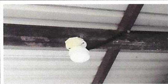
Foto 5: Sustitución de focos ahorradores
