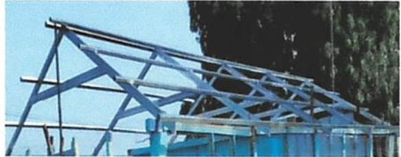
Foto 2: Sustitución de estructura de soporte de madera, por metal
