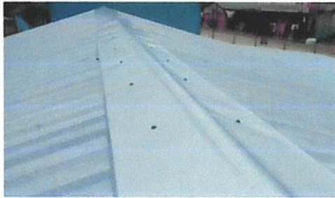
Foto 3: Sustitución de capote de lámina para lámina troquelada
