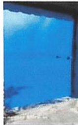
Foto 5: Sustitución de puerta de metal
