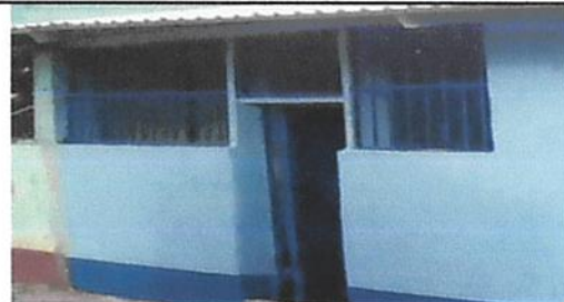
Foto 6: Sustitución de balcones de metal
