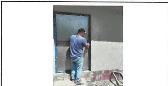
Foto 5:Sustitución de puerta de metal
