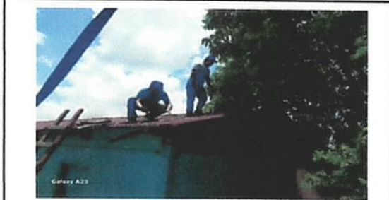
Foto1: Sustitución de lamina, por lamina troquelada aluzinc calibre 26 modulo de aulas y direccion
