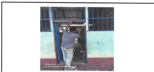
Foto 6:Sustitución de balcones de metal
