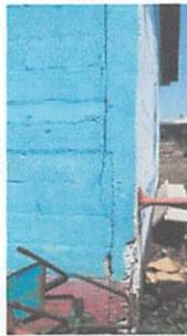
Foto 15: Sellado de grietas y fisuras en muros
