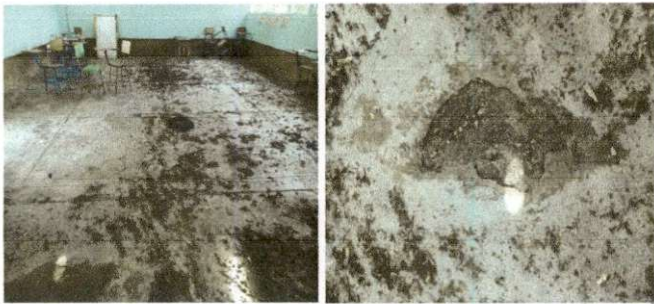
Foto 3: SUSTITUCION DE PISO DE CEMENTO LIQUIDO
