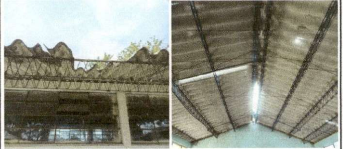
Foto 2: SUSTITUCION DE ESTRUCTURA DE SOPORTE DE METAL, POR METAL
