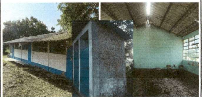
Foto 4: PINTURA EN MUROS DE EXTERIORES E INTERIORES
