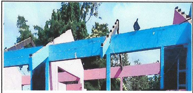
Foto 2: Sustrucción de estructura de soporte de metal, por metal
