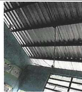
Foto 6: SUSTITUCION DE DUCTO ELECTRICO MAS ACCESORIOS
