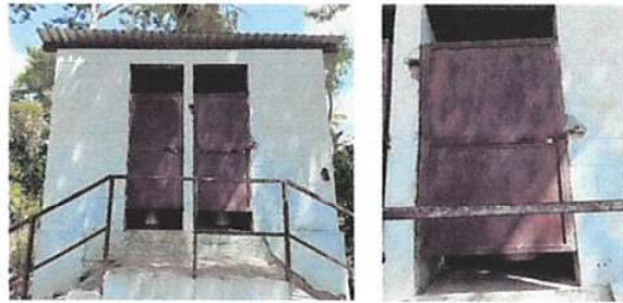
Foto 4: SUSTITUCION DE PUERTA EN SERVICIOS SANITARIOS
