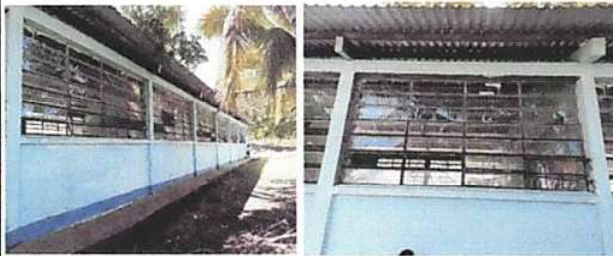
Foto 1: SUSTITUCION DE VIDRIOS
