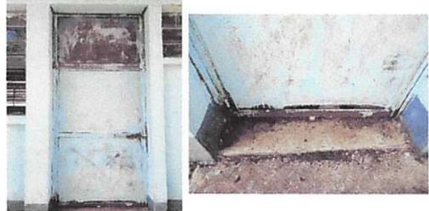
Foto 2: SUSTITUCION DE PUERTA
