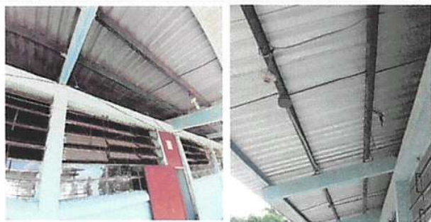
Foto 5: SUSTITUCION DE LAMPARA 2X40
