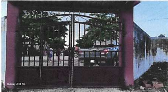
SUSTITUCIÓN DEL PORTÓN DE METAL
