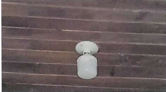
SUSTITUCIÓN DE FOCOS AHORRADORES
