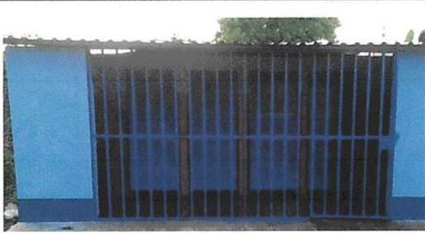
MANTENIMIENTO DE BARANDA DE METAL
