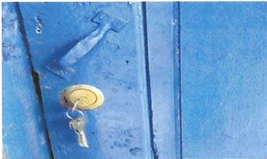
SUSTITUCIÓN DE CHAPAS
