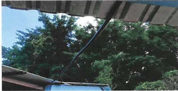
SUSTITUCIÓN DE DUCTO ELÉCTRICO MAS ACCESORIOS
