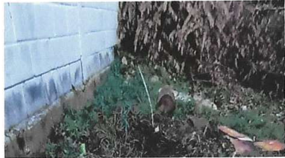
SUSTITUCIÓN DE TUBERIA LINEA PRINCIPAL
