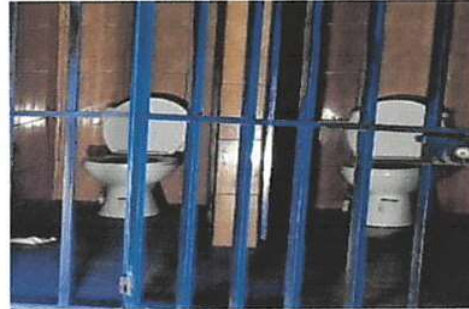
SUSTITUCIÓN DE INODORO
