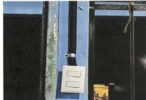
INSTALACIÓN DE UNIDADES DE LUZ. Incluye interruptor y cableado eléctrico
