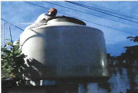
SUSTITUCIÓN DE ACCESORIOS A DEPOSITO DE AGUA
