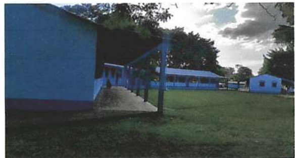
PINTURA EN MURO EXTERIOR E INTERIOR
