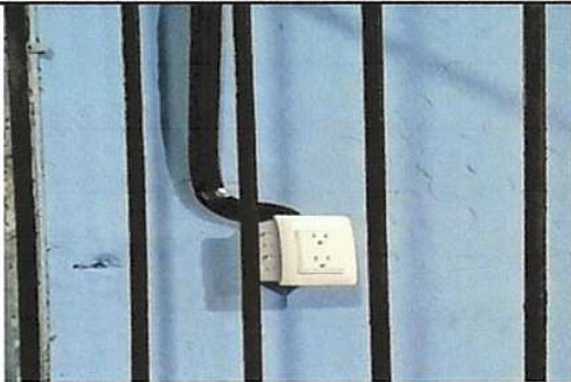
INSTALACION DE UNIDADES DE FUERZA
