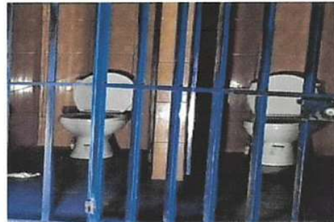
INSTALACIÓN DE INODOROS
