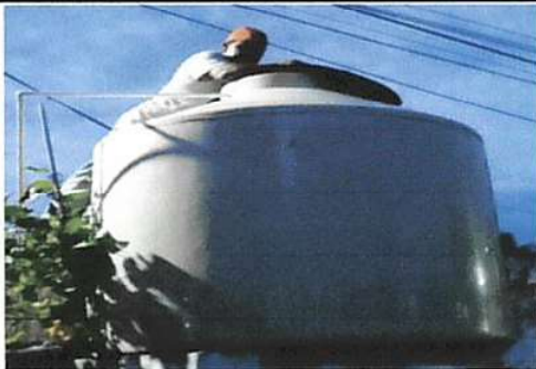
SUSTITUCIÓN DE ACCESORIOS A DEPOSITO DE AGUA
