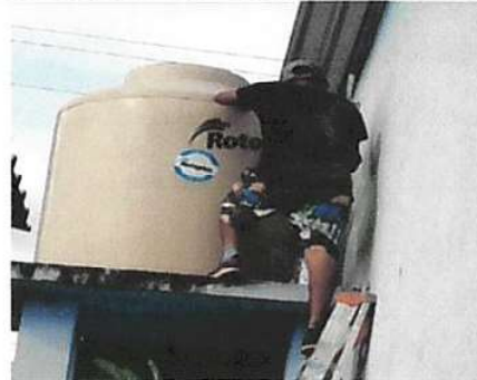
SUSTITUCIÓN DE DEPOSITO DE AGUA
