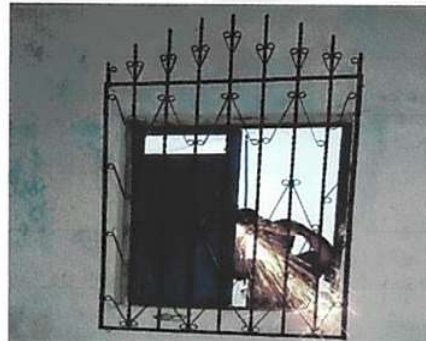
SUSTITUCIÓN DE VENTANA DE MADERA POR VENTANA DE METAL MAS VIDRIO
