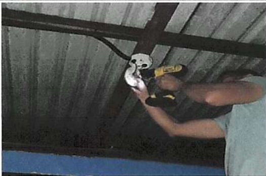
SUSTITUCIÓN DE PLAFONERAS
