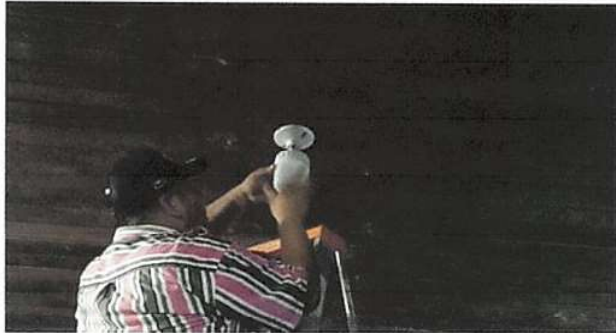
SUSTITUCIÓN DE FOCOS AHORRADORES
