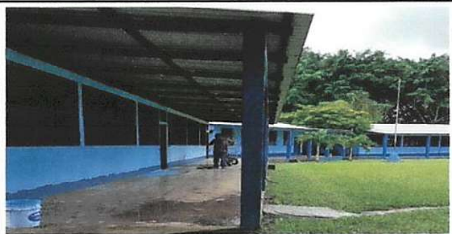
PINTURA EN MURO EXTERIOR E INTERIOR
