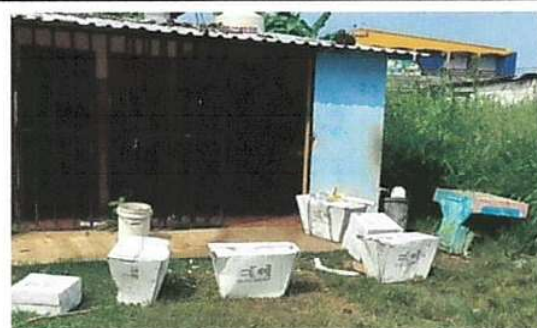
SUSTITUCIÓN DE INODORO
