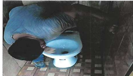
INSTALACIÓN DE INODOROS
