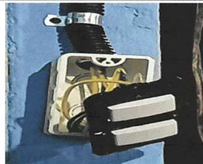
INSTALACIÓN DE UNIDADES DE LUZ. Incluye interruptor y cableado eléctrico
