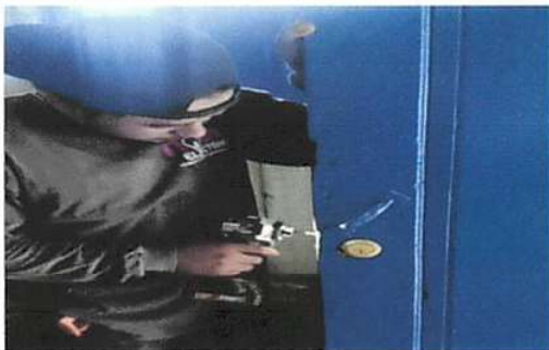
SUSTITUCIÓN DE CHAPAS
