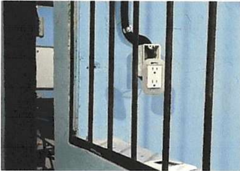
INSTALACION DE UNIDADES DE FUERZA
