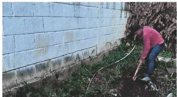
SUSTITUCIÓN DE TUBERIA LINEA PRINCIPAL
