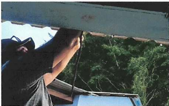
SUSTITUCIÓN DE DUCTO ELÉCTRICO MAS ACCESORIOS
