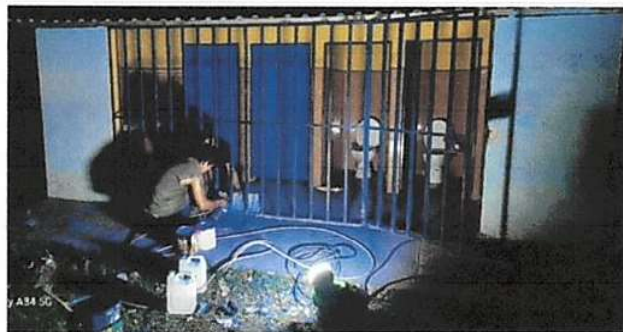
MANTENIMIENTO DE BARANDA DE METAL
