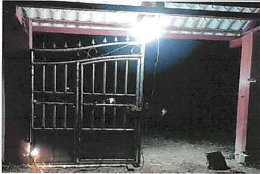
SUSTITUCIÓN DEL PORTÓN DE METAL
