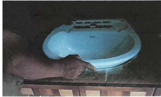
SUSTITUCIÓN DE LAVAMANOS
