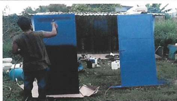
MANTENIMIENTO A ESTRUCTURA lijado, cepillado y aplicación de pintura
