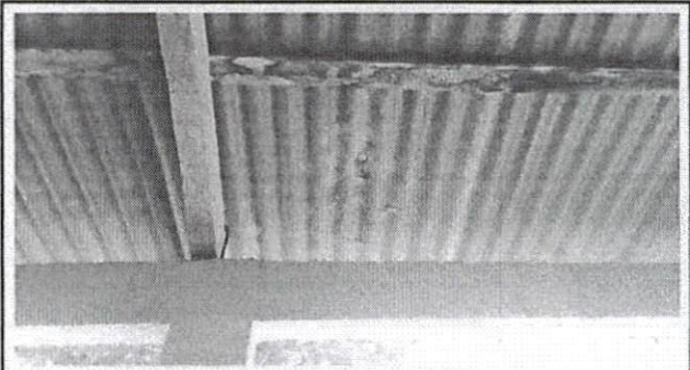
Sustitución de elementos de fijación.
