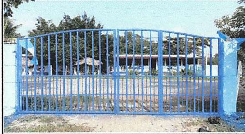
Foto 1: Mantenimiento a portones de metal
