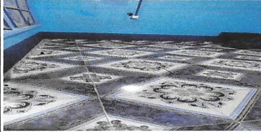
Foto 7: Sustrucción de piso cerámico
