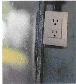
Foto 15: Sustrucción de tomacorrientes dobles
