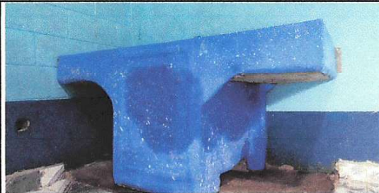
Foto 9: Sustrucción de pila de cemento de dos lavadero
