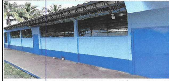
Foto 4: Pintura en muros exteriores e interiores
