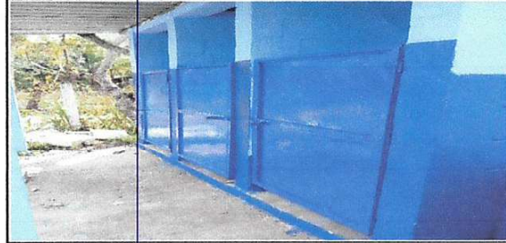
Foto 2: Mantenimiento a estructura puertas servicios sanitarios
