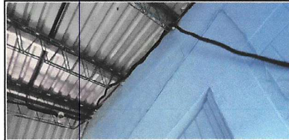
Foto 18: Reparación de cableado eléctrico
