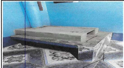
Foto 10: Sustrucción de estufa rural (completa) incluye chimenea y plancha de metal
