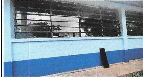
Foto 8: Sustrucción de vidrios
