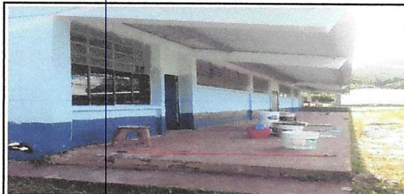
Foto 4: Pintura en muros exteriores e interiores
