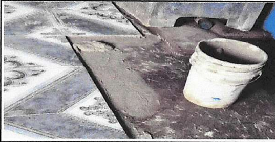
Foto 7: Sustrucción de piso cerámico
