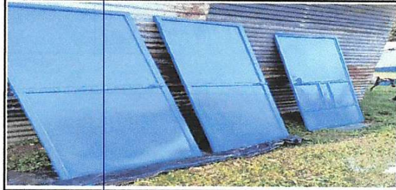
Foto 2: Mantenimiento a estructura puertas servicios sanitarios
