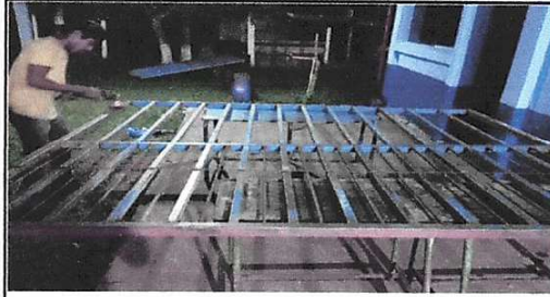
Foto1: Mantenimiento a portones de metal
