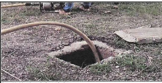
Foto 11: Limpieza de fosa séptica
