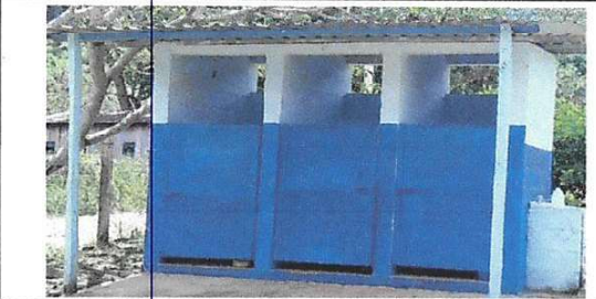
Foto 2: Mantenimiento a estructura puertas servicios sanitarios
