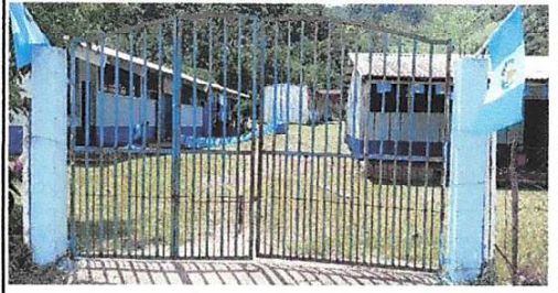
Foto 1: Mantenimiento a portones de metal
