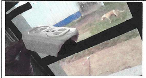
Foto 15: Sustrucción de tomacorrientes dobles
