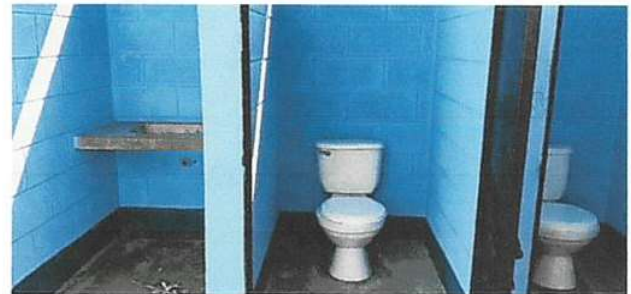
Foto 6: Sustitución de inodoro
