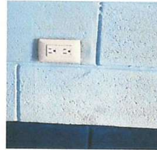
Foto 4: Reparación de cableado eléctrico
