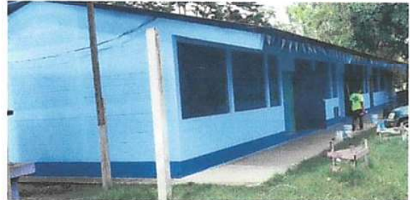
Foto 4: Reparación de cableado eléctrico
