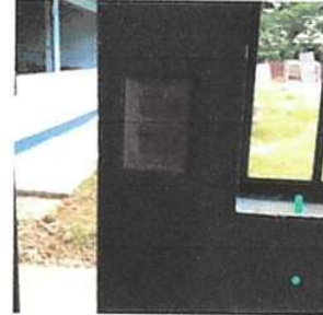
Foto 2: Sustitución interruptores simples
