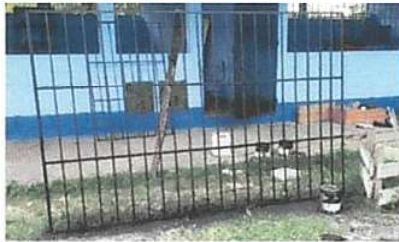
Foto 3: Mantenimiento a barandas
