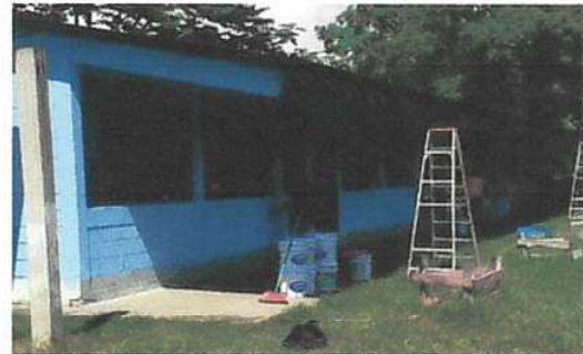
Foto 4: Pintura de paredes
