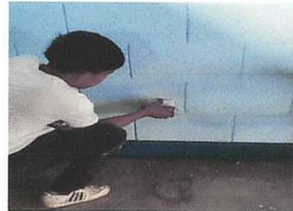
Foto 4: Reparación de cableado eléctrico
