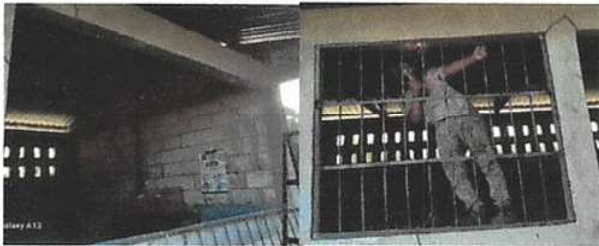
Foto 3: Mantenimiento a barandas (pintura de balcones)
