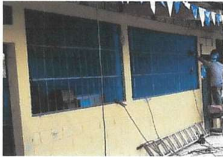
Foto1: Fabricación e instalación de balcones de hierro
