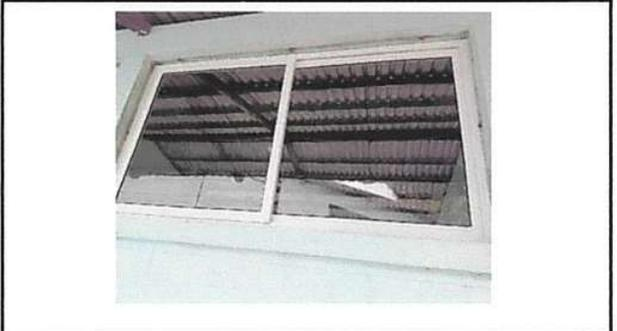
Foto 2: Sustitución de estructura de metal de ventana
