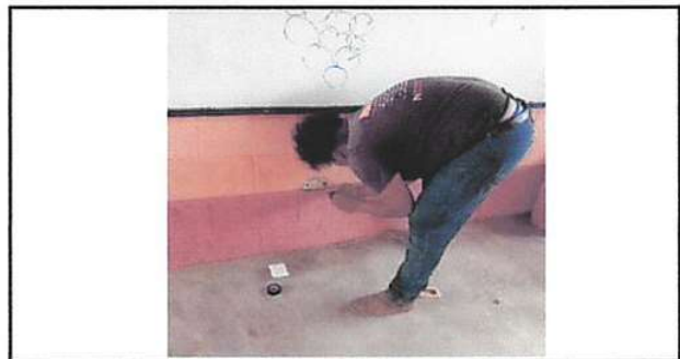
Foto 6: sustitucion de tomacorrientes dobles
