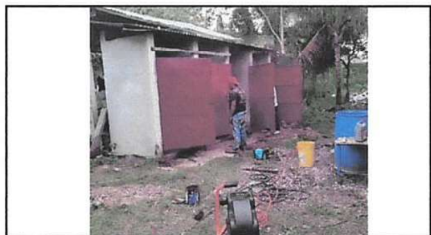
Foto 4: sustitucion a puertas servicio sanitarios
