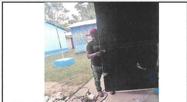
Foto 1: sustitucion de chapa
