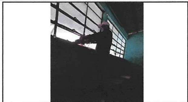
Foto 2: sustitucion de estructura de metal de ventanas
