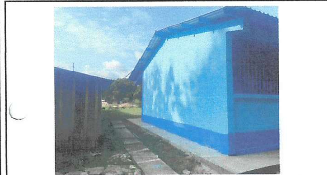
Foto 11: Pintura en muros exteriores e interiores.
