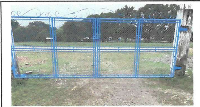
Foto7: Sustitución de portón de metal.
