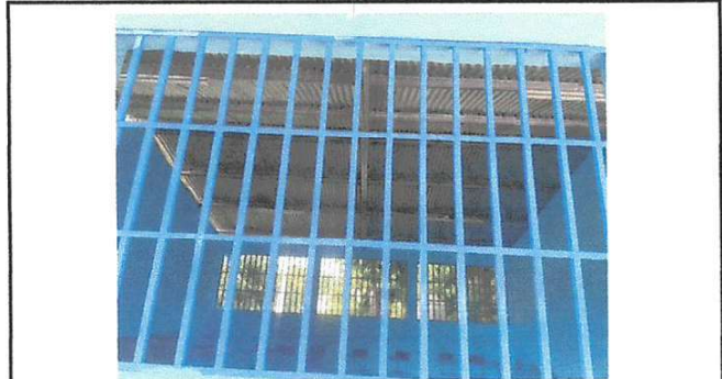
Foto 8: Mantenimiento a balcones de metal.
