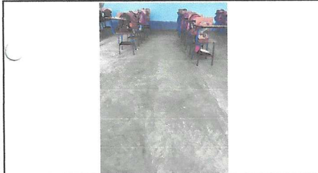
Foto 9: Reparación de piso de cemento líquido.
