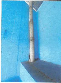
Foto13: Sustitución de chimenea de concreto.
