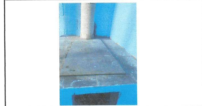
Foto 12: Sustitución de plancha de metal de 3 hornillas.
