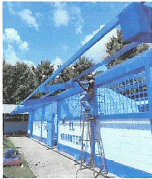
Foto 3: Mantenimiento a estructura de soporte de metal.
