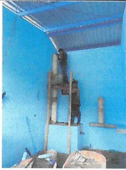
Foto13: Sustitución de chimenea de concreto.
