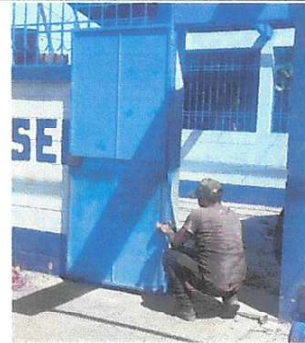
Foto 4: Mantenimiento a estructura (lijado, cambio de tubo, cepillado, sujeciones, aplicación de pintura)
