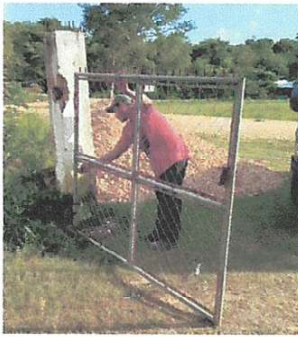
Foto7: Sustitución de portón de metal.
