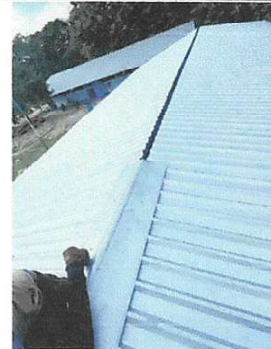
Foto 2: Sustitución de capote de lámina para lámina troquelada.
