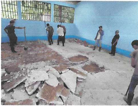
Foto 9: Reparación de piso de cemento líquido.
