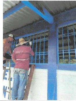
Foto 8: Mantenimiento a balcones de metal.
