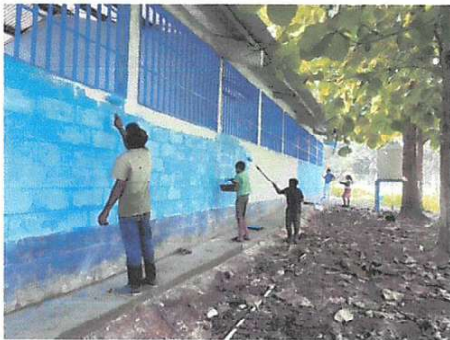
Foto 11: Pintura en muros exteriores e interiores.
