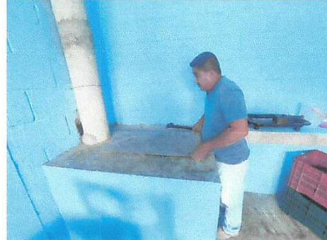
Foto 12: Sustitución de plancha de metal de 3 hornillas.
