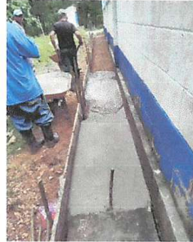
Foto 10: Reparación de banquetas de concreto.
