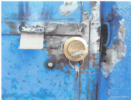
Foto 5: Sustitución de chapas.
