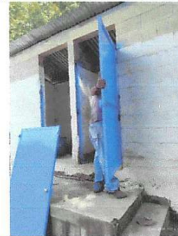
Foto 6: Sustitución de puerta en servicios sanitarios.
