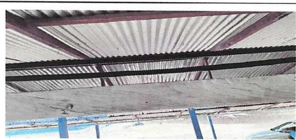
Foto 14: Sustitución de ducto eléctrico + accesorios
