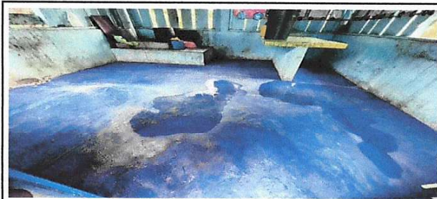
Foto 16: Sustitución de piso de torta de concreto
