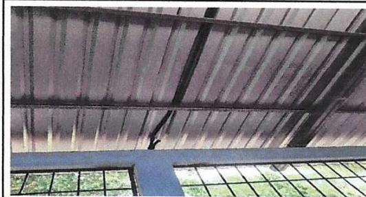
Foto 13: Reparación de cableado eléctrico
