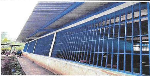
Foto 3: Mantenimiento a balcones de metal
