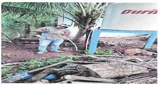
Foto 15: Sustitución de depósito de agua 1100 lt
