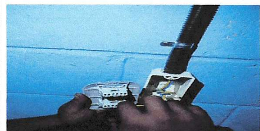
Foto 10: Sustrucción interruptores dobles
