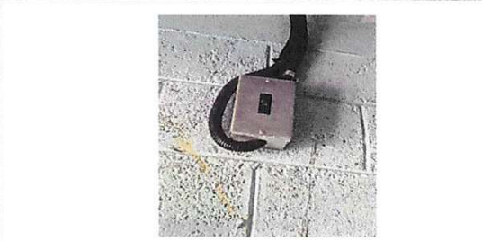
Foto 12: Sustrucción de flipones
