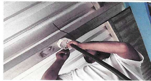
Foto 13: Reparación de cableado eléctrico
