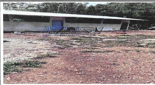
Foto 3: Mantenimiento a balcones de metal
