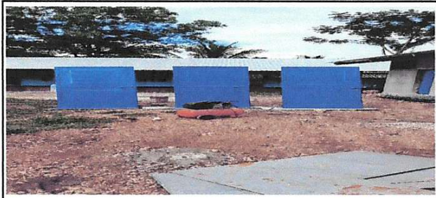
Foto 2: Mantenimiento a estructura (lijado, cambio de tubo, cepillado, sujeciones, aplicación de pintura)
