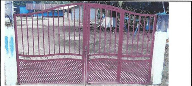
Foto 4: Mantenimiento a portones de metal
