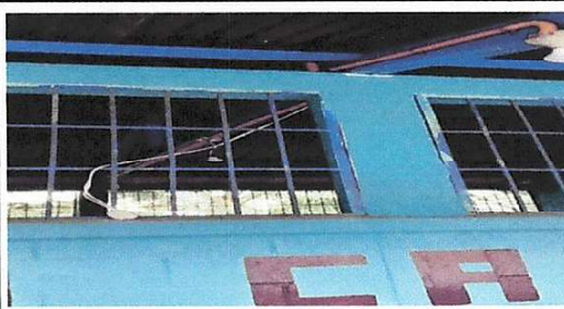
Foto 10: Sustitución interruptores dobles
