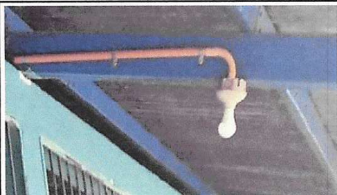
Foto 9: Sustitución de plafoneras
