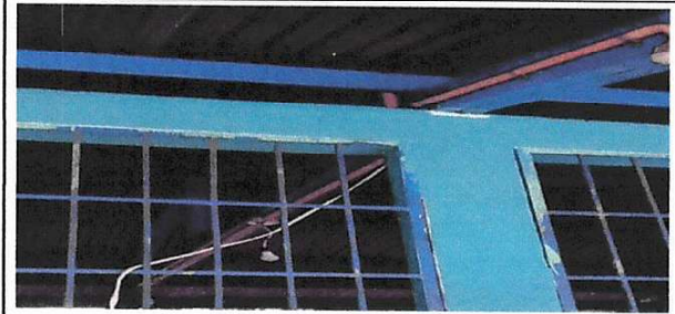
Foto 14: Sustitución de ducto eléctrico + accesorios
