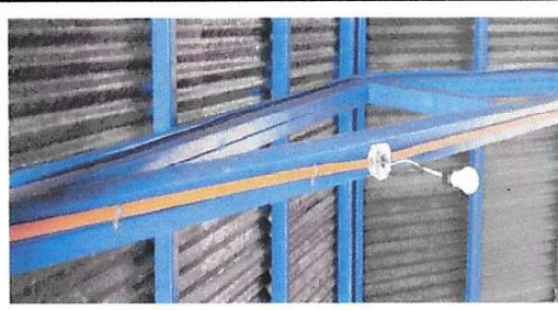
Foto 8: Sustitución de focos ahorradores
