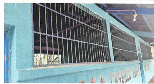
Foto 3: Mantenimiento a balcones de metal
