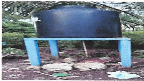
Foto 15: Sustitución de depósito de agua 1100 lt
