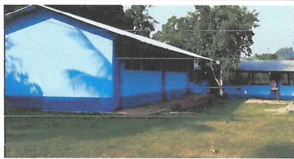
Foto 3: Pintura en muros exteriores e interiores
