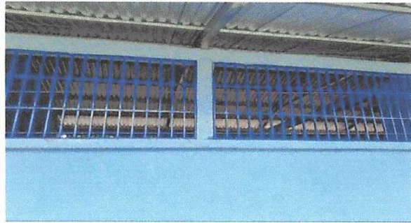
Foto 1: Sustitución de balcones de metal
