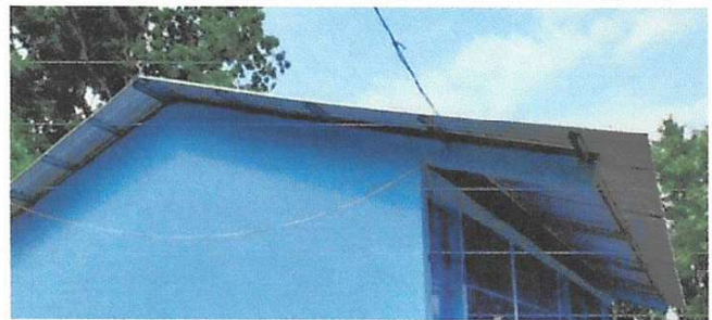
Foto 4: Sustitución de lámina, por lámina troquelada aluzinc calibre 26
