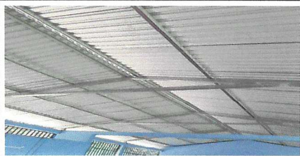
Foto 5: Sustitución de estructura de soporte de metal, por metal
