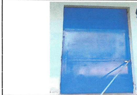
Foto 2: Sustitución de puertas
