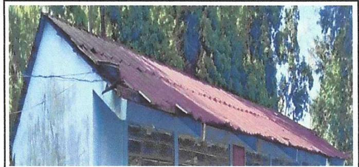
Foto 4: Sustitución de lámina, por lámina troquelada aluzinc calibre 26
