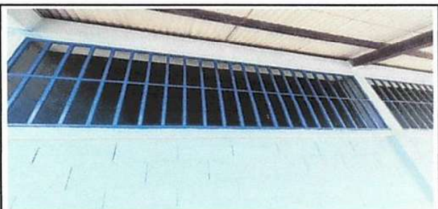
Foto 4:Mantenimiento a balcones de metal
