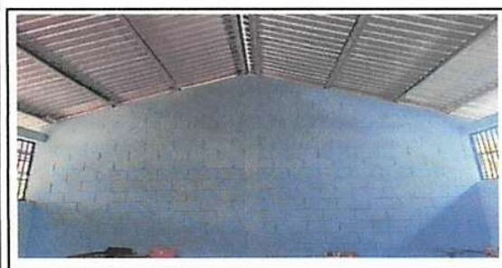
Foto 5:Pintura en muros exteriores e interiores
