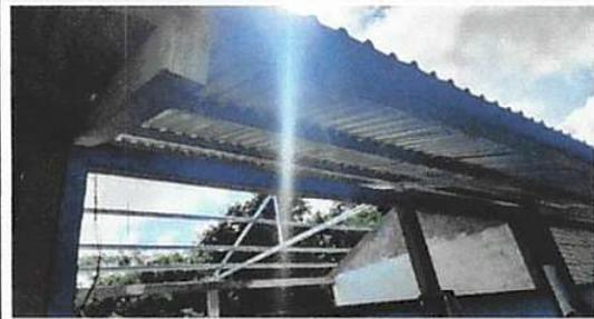
Foto 1: Sustitución de lámina troquelada aluzinc cal. 26
