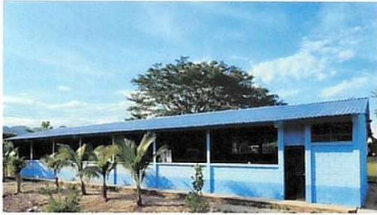
Foto1: CUBIERTA DE LAMINA. Sustitución de lamina, por lamina troquelada aluzinc, sustitución de capotes de lamina para lamina troquelada, sustitución de elememtos de fijación.
