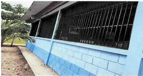
Foto 3: VENTANAS. sustitución de estructura de metal de ventana
