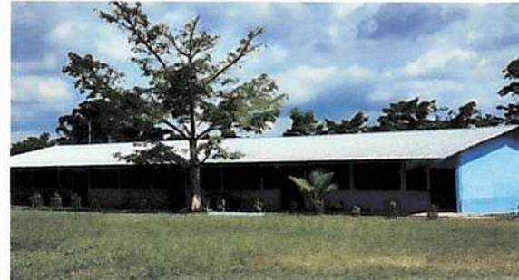
Foto 2: CUBIERTA DE LAMINA. Sustitución de lamina, por lamina troquelada aluzinc, sustitución de capotes de lamina para lamina troquelada, sustitución de elememtos de fijación.
