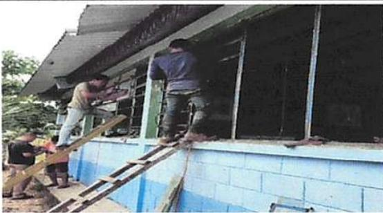
Foto 3: VENTANAS. sustitución de estructura de metal de ventana
