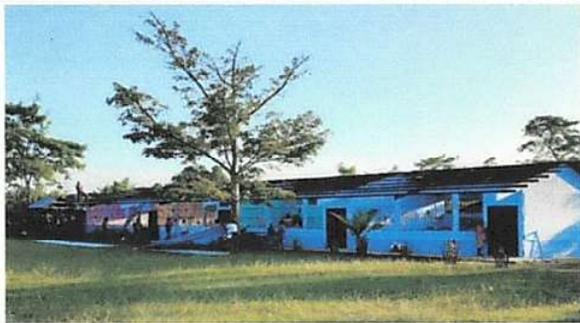
Foto1: CUBIERTA DE LAMINA. Sustitución de lamina, por lamina troquelada aluzinc, sustitución de capotes de lamina para lamina troquelada, sustitución de elementos de fijación.
