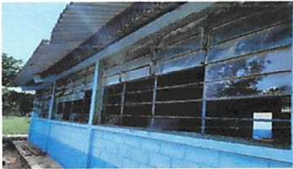
Foto 3: VENTANAS. sustitución de estructura de metal de ventana
