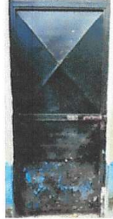
Foto 2: Sustitución de puertas
