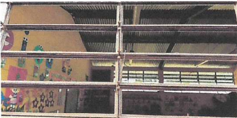
Foto 3: Mantenimiento a estructura de metal de ventana
