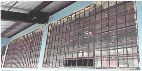
Foto 5: Mantenimiento a balcones de metal
