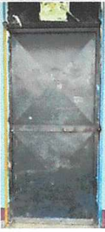
Foto 1: Mantenimiento a estructura
