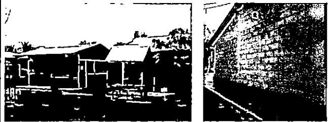
Foto 2: Pintura de muros exteriores e interiores de 7 aulas, dirección, cocinas, 2 bodegas y 2 módulos de baño.
