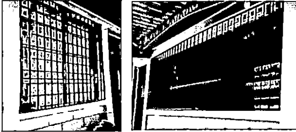
Foto 1: Reparación de Ventanales de vidrio y divisiones de un módulo de 3 aulas, 2 bodegas, dirección
