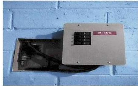
Foto 10: Sustitución de tablero de flipones
