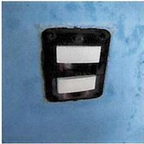
Foto 7: Sustitución interruptores dobles
