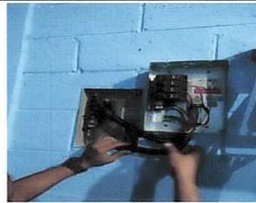
Foto 10: Sustrucción de tablero de flipones
