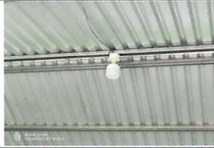
Foto 8: Sustitución de focos ahorradores
