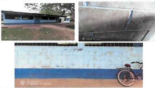
Foto 3: Pintura en muros exteriores e interiores
