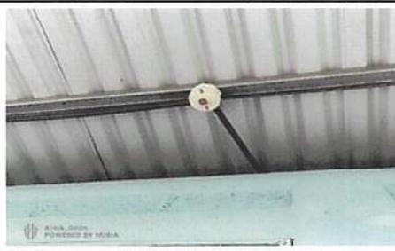
Foto 6: Sustitución de plafoneras
