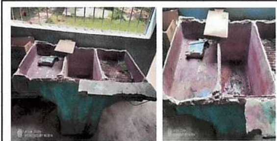
Foto 15: Sustitución de pila de cemento de un lavadero
