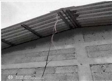
Foto 11: reparación de cableado eléctrico
