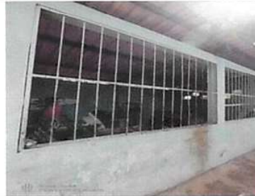
Foto 12: Mantenimiento a balcones de metal
