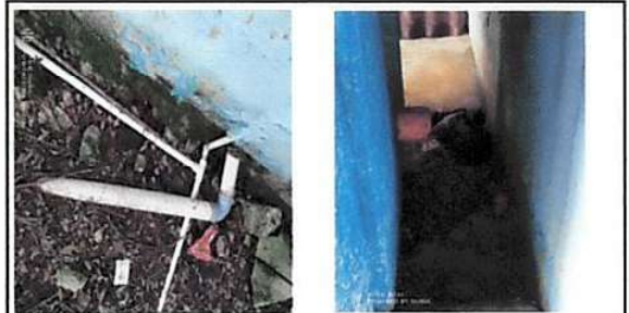
Foto 16: Sustitución de tubería PVC línea principal aguas negras
