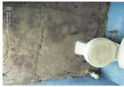
Foto 2: sustitucion de piso de cemento liquido
