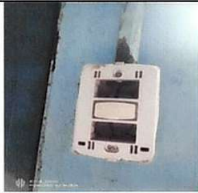
Foto 5: Sustitución interruptores simples
