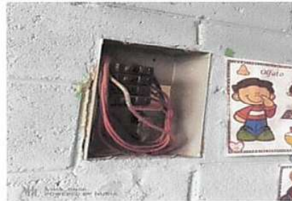
Foto 10: Sustitución de tablero de flipones
