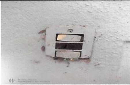
Foto 7: Sustitución interruptores dobles
